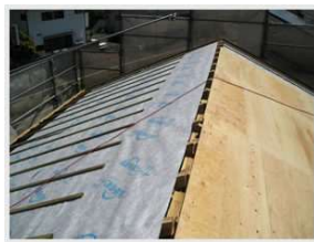
遮熱シート・遮熱通気層・棟換気
